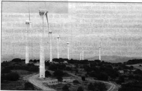
Les éoliennes pourraient s'installer au Plessis-Grimoult d'ici 2011.
